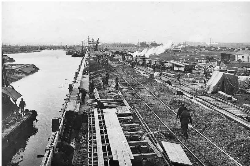
Travaux d'installation du terminal pour train-ferry à Richborough (Photo www.shippingtandy.com )
