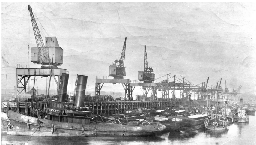
Les premières installations à Richborough (Document tiré du livre « Engineering Richborough » de Collin Varrall).
