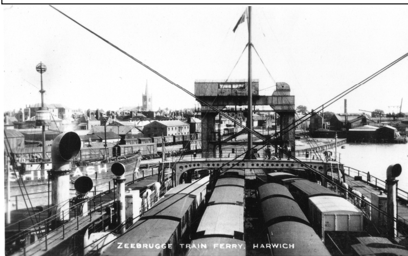
Le terminal de Harwich (Coll. P-Y. Lepage).
